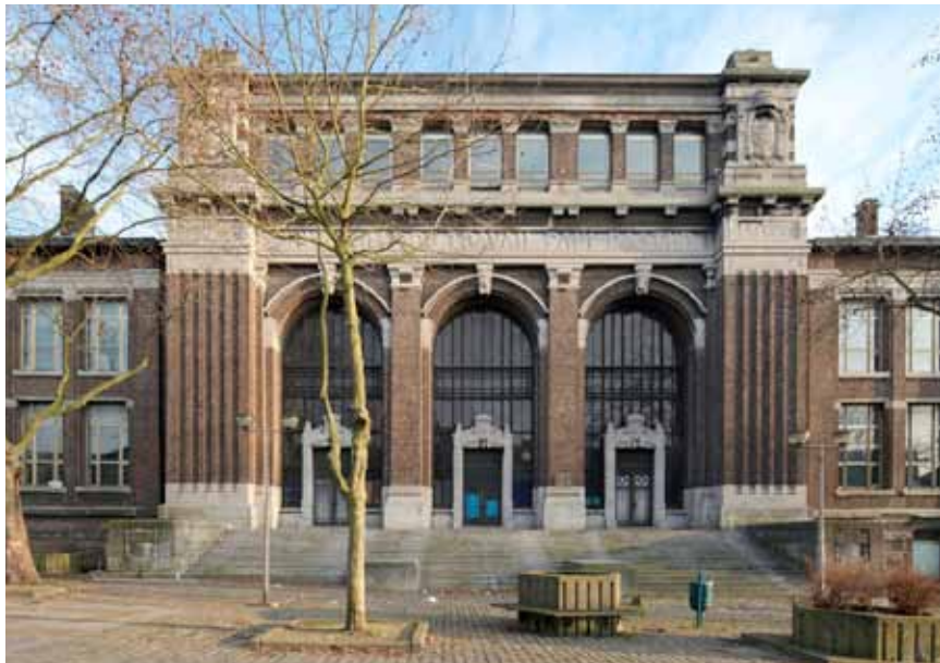
LE BÂTIMENT ZÉNOBE GRAMME (UT), À CHARLEROI.
