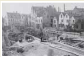
Travaux de voûtement de la Senne au niveau de la bourse, 1869.
