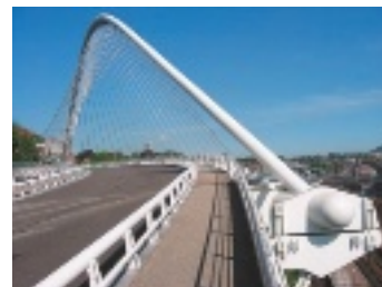
Liège Pont de l'Observatoire
