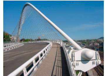
Liège Pont de l'Observatoire
