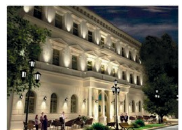
Budapest (Hongrie) Résidence Avenue Gardens
